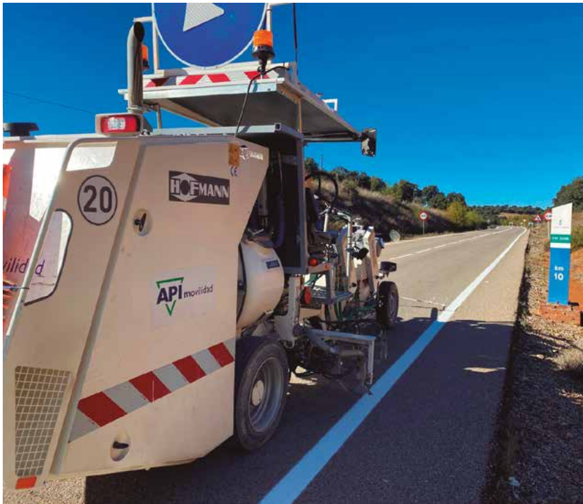
Trabajos de señalización horizontal en carreteras de la JCCM
