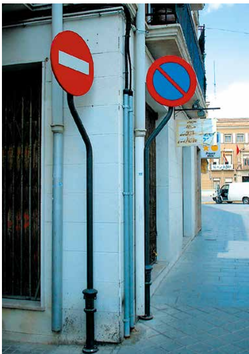
Poste pegado a pared para no interferir en la superficie de la acera
