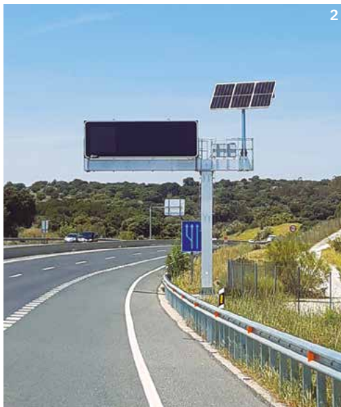
2 Banderola de aluminio para PMV con placas solares
