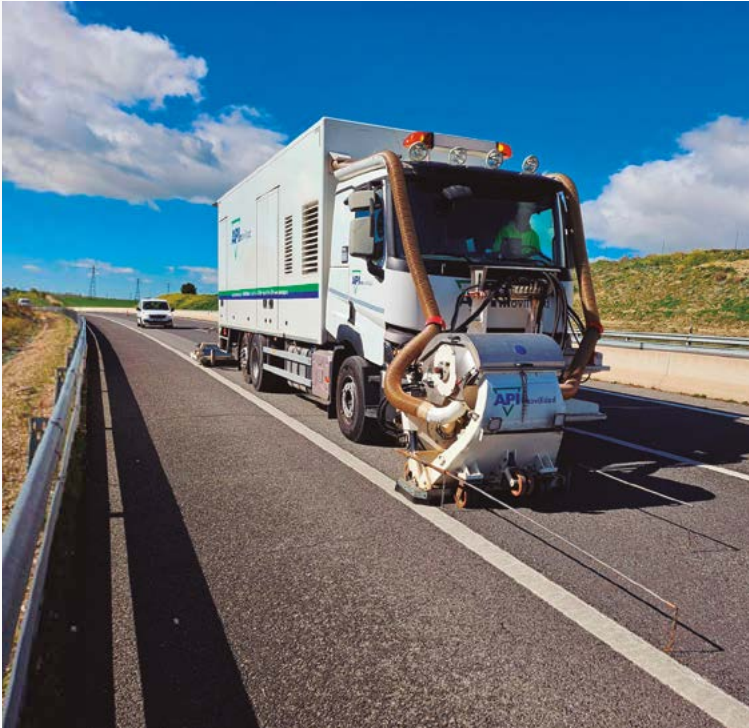
Mejora de CRT mediante granallado en carreteras de la CAM
