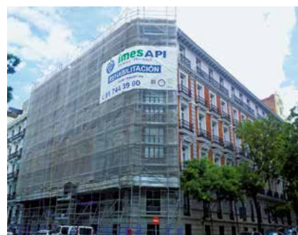
4 Rehabilitación de fachadas
