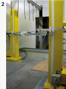
2 Aplicación de pintura mediante robot
