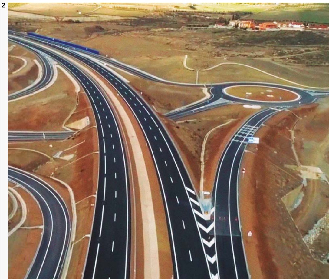
2 Señalización horizontal en obra nueva de carreteras
