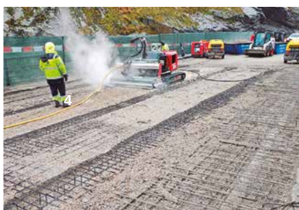
5 Trabajos de hidrodemolición
