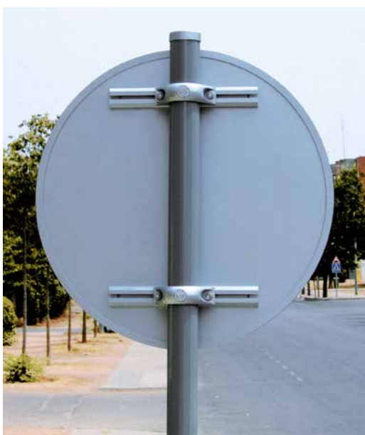
Amarre señal-poste con abrazaderas
