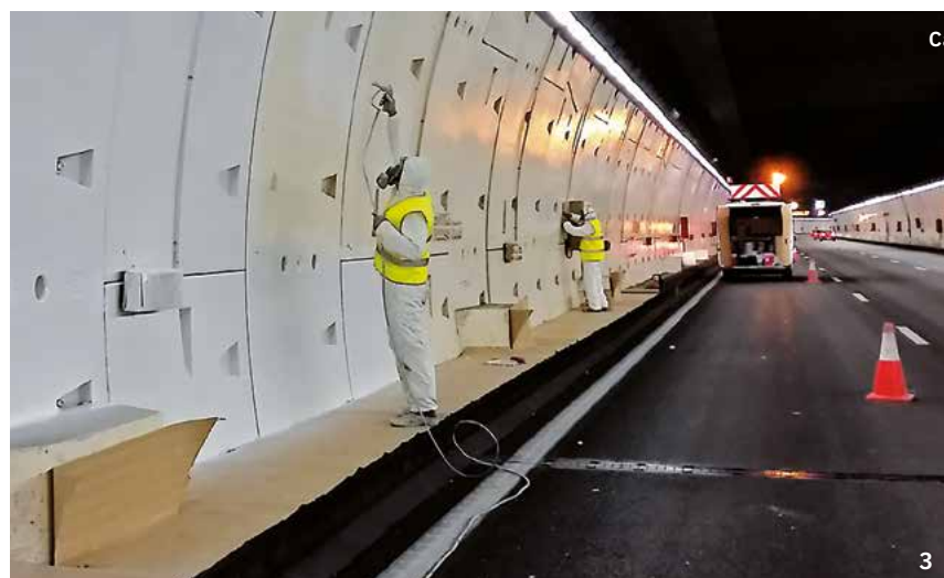
5 Trabajos de hidrodemolición
