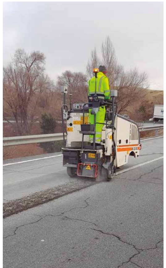
Trabajos de fresado de huella sonora
