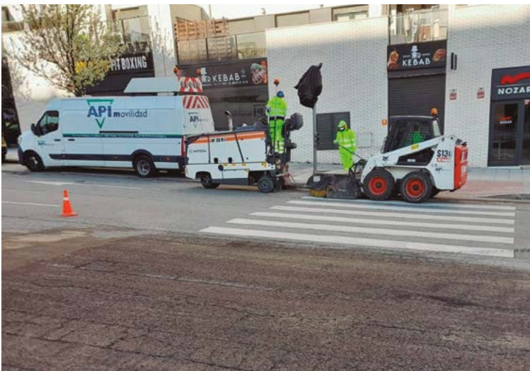
Microfresado de marcas viales
