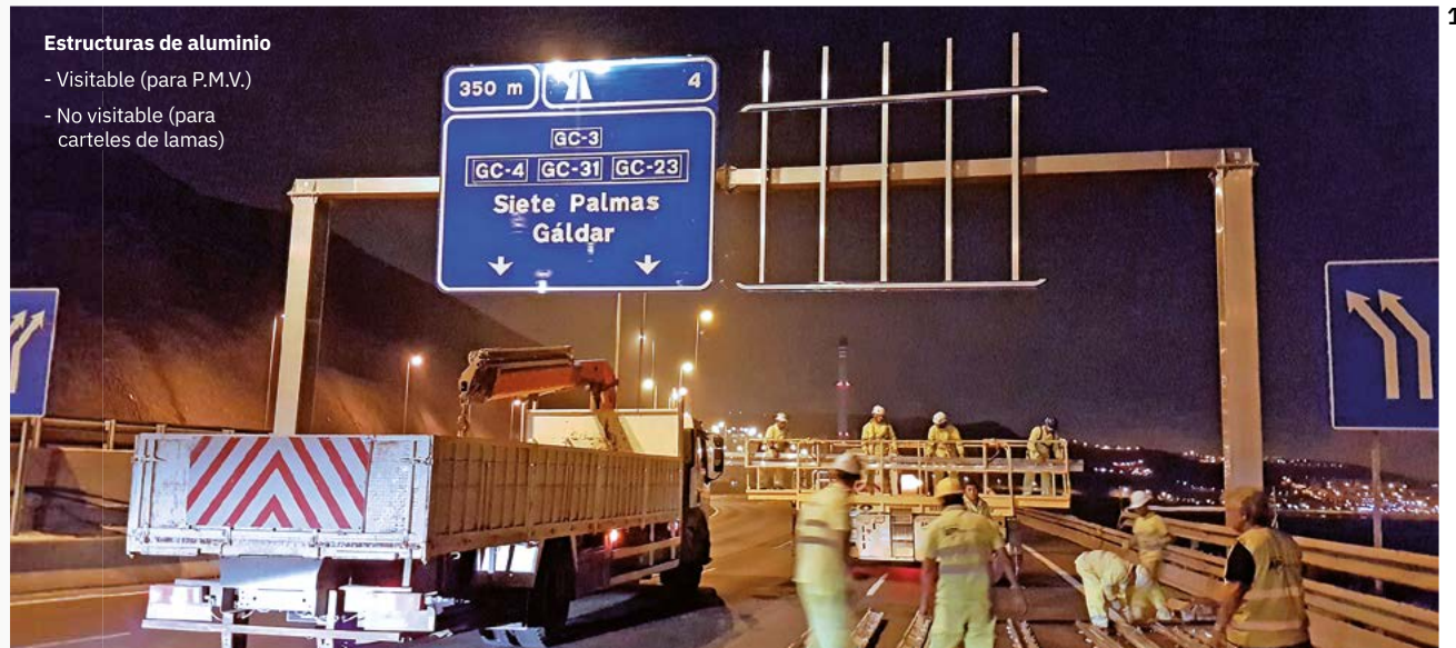
2 Banderola de aluminio para PMV con placas solares
