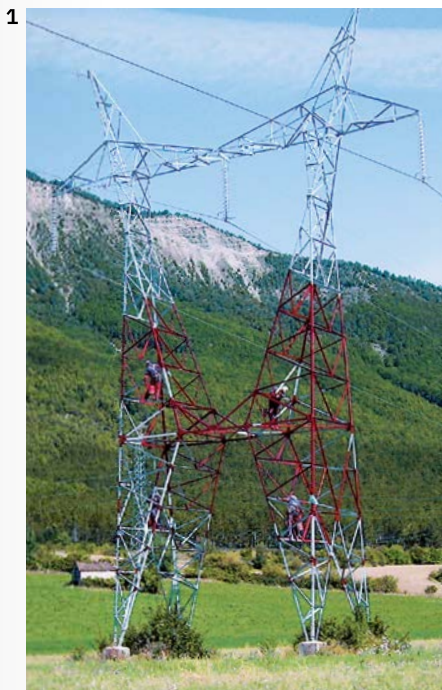
1 Pintado de torres de alta tensión para Red Eléctrica
