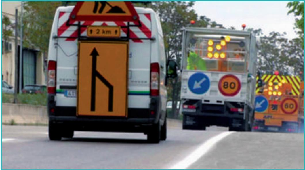
Proceso de señalización móvil durante trabajos de repintado con pintura termoplástica en caliente
