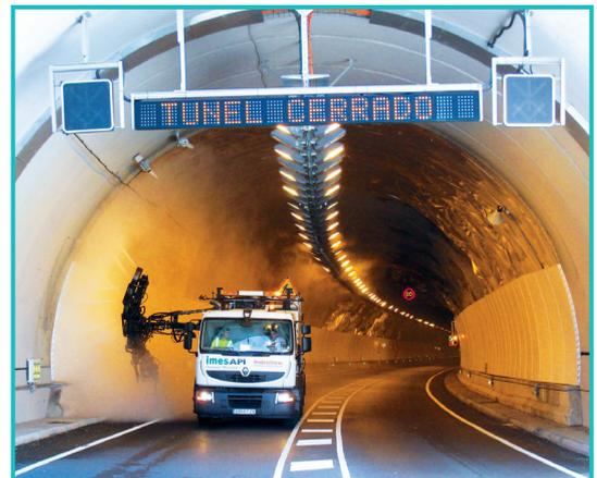
Camión con sistema «Hidroflow» para limpieza de túneles
