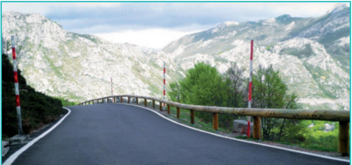
Barrera mixta metálica-madera. N2 W7
