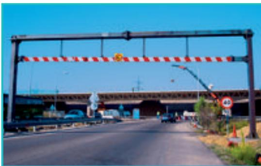
Pórticos de gálibo con fusible de seguridad
