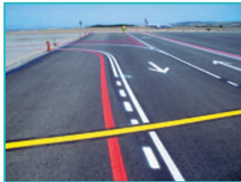
Señalización de aeropuertos con pintura al agua en varios colores
