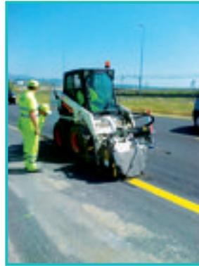
Fresado de marcas viales mediante mini con implemento fresador
