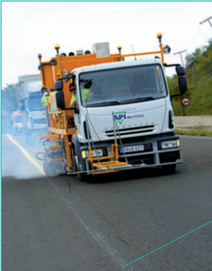
Trabajos de repintado con pintura termoplástica en caliente
